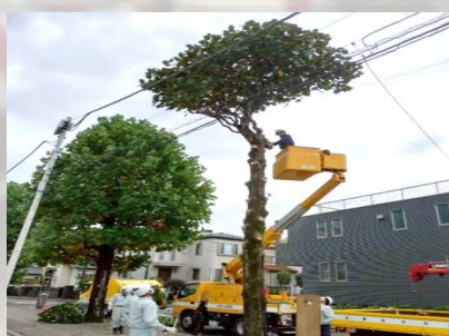
伐採作業の様子
