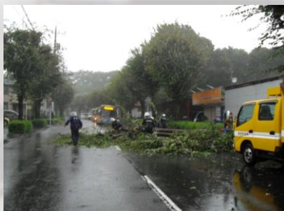
強風による緊急作業の様子
