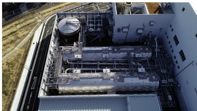
町田市バイオエネルギーセンター(バイオガス化施設の発酵槽)
