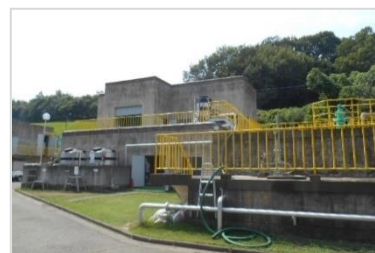
排水浄化センター外観
