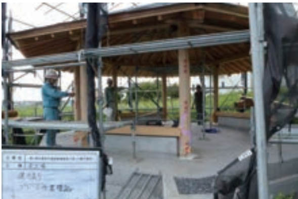
ブレースの取り付け状況
