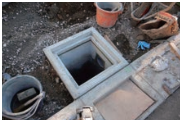
枺A・塩ビ管設置状況
