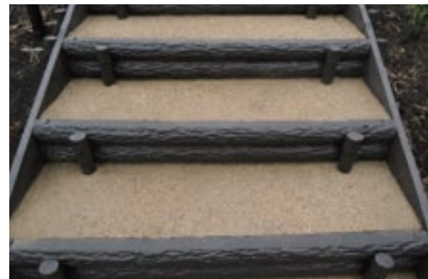
丸太階段舗装状況
