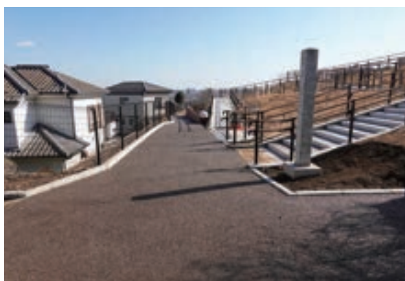
脱色アスファルト舗装施工完了
