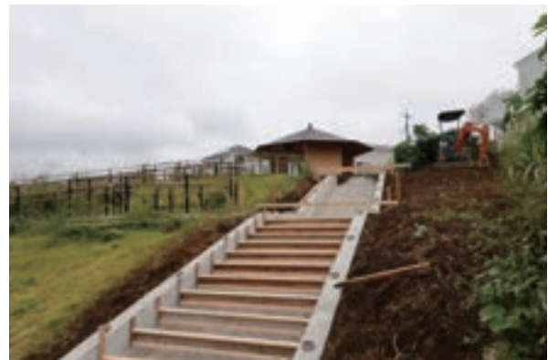
階段 踏面および蹴上寸法確認
