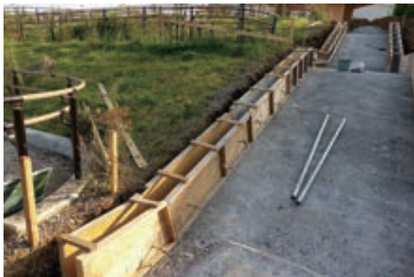
階段 基礎工事 袖壁型枠状況
