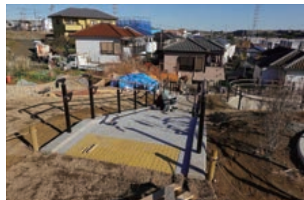
階段 擬石平板および点状ブロック施工
