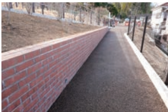
脱色アスファルト舗装施工完了
