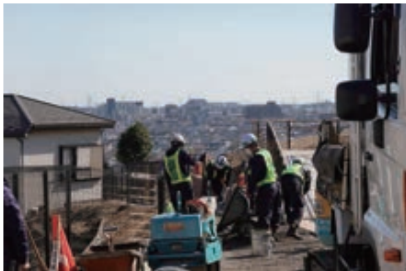
脱色アスファルト舗装施工
