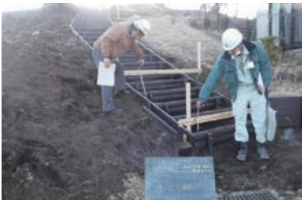
丸太階段施工状況
