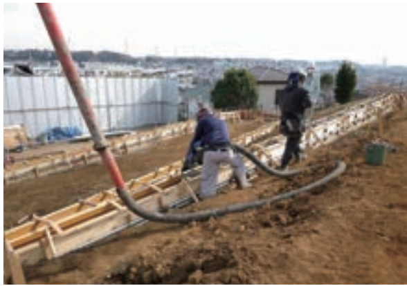
スロープ袖壁コンクリート打設
