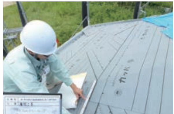
アスファルトルーフィングの重ね代確認
