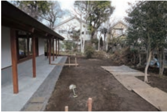
雨落A・軟質土質舗装
