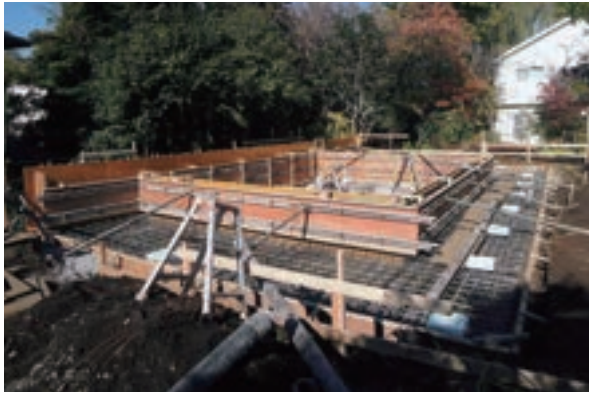
立上り基礎型枠状況
