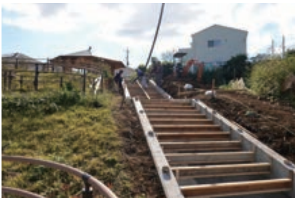
階段 コンクリート打設
