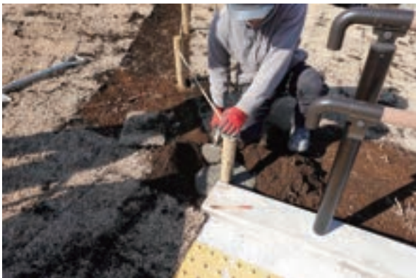
ロープ柵端柱のモルタルによる根巻
