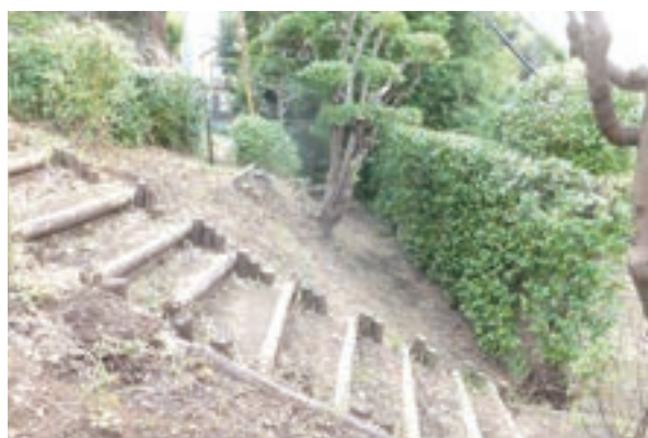
階段の老朽化
