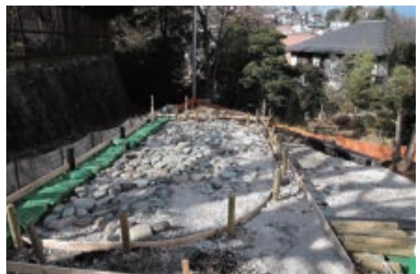
配石遺構復元 路盤・舗装止め形状
