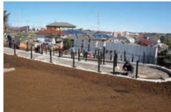
スロープ手すり高欄柱設置
