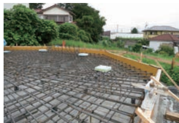
配筋と型枠の状況
