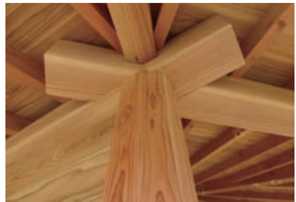
桁・隅木・柱の納まり状況
