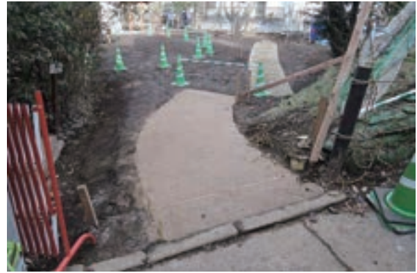
スロープ硬質土質舗装
