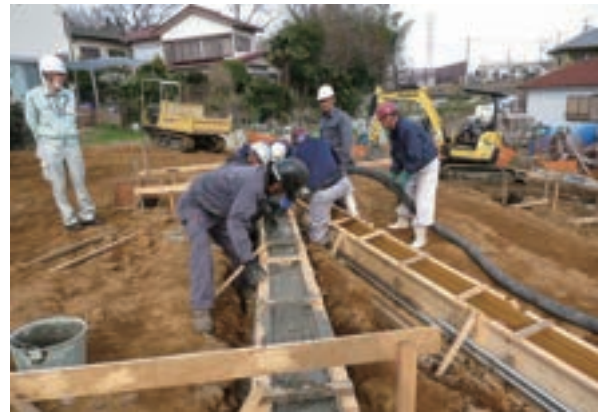
スロープ袖壁コンクリート打設
