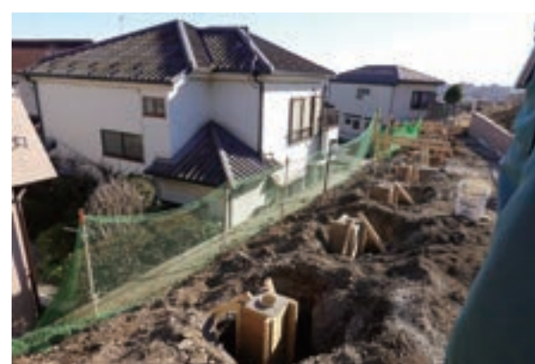
北東側敷地境界擁壁部 フェンス基礎施工
