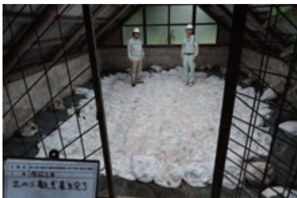
整備前 土のう敷設養生完了
