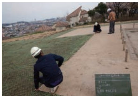
硬質土系舗装検査状況
