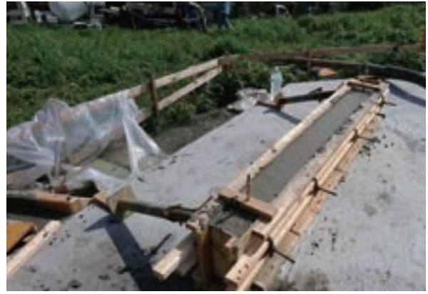
立上り部分のコンクリート打設
