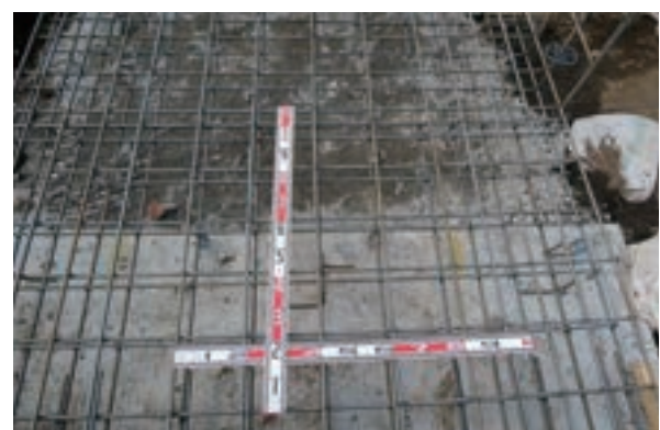
スラブ筋のピッチ確認（@タテヨコ 200mm）
