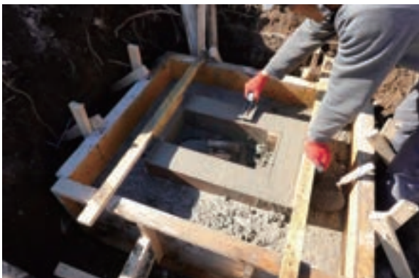
石柱基礎コンクリート打設
