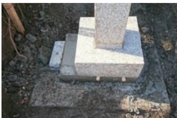
石柱移設（コンクリート基礎 2 回目打設完了）
