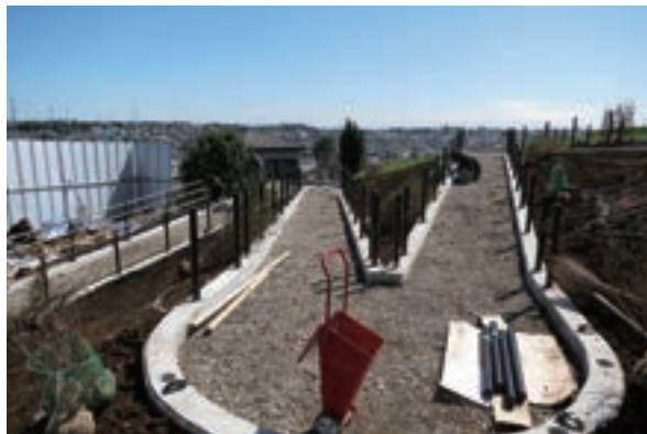
スロープ手すり高欄柱設置
