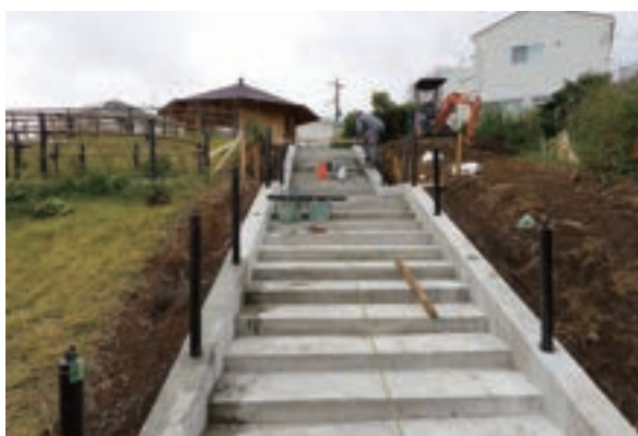
階段 手すり高欄柱設置
