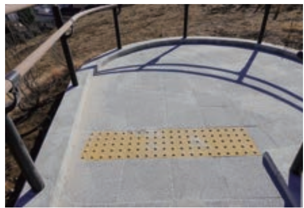
スロープ 擬石平板および点状ブロック施工
