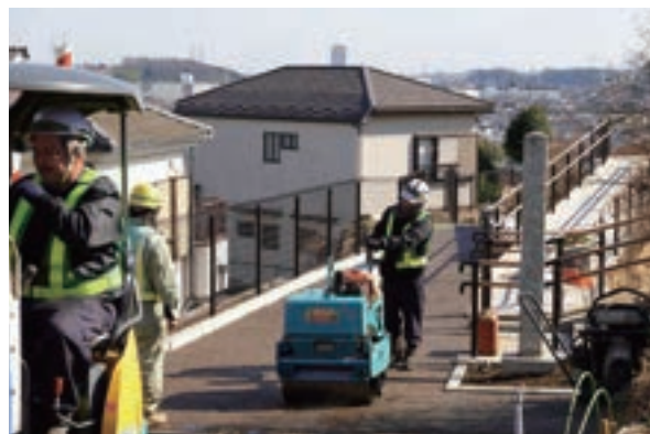
脱色アスファルト舗装施工
