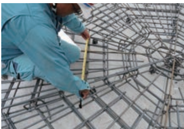
配筋検査 継手長さ確認
