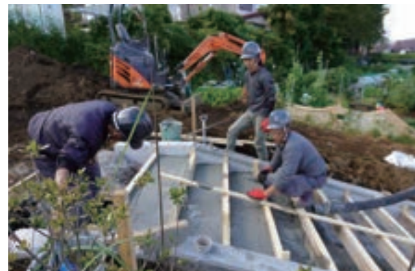
階段 コンクリート打設
