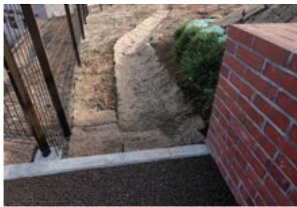
路面終点位置と素掘側溝および植生土のう積
