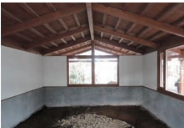
壁左官工事完了 遺構保護着手前
