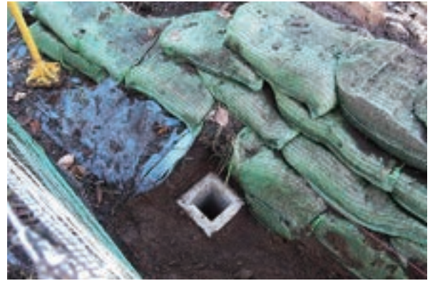
植生土のう積み・ロープ柵基礎ブロック埋設
