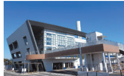
町田市バイオエネルギーセンター
