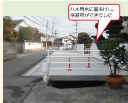
幅員の狭い道路の改良
