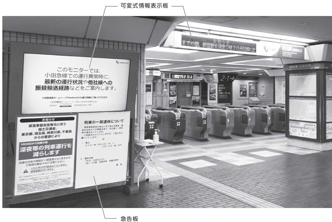
【写真14.2】 可変式情報表示板の配置例
