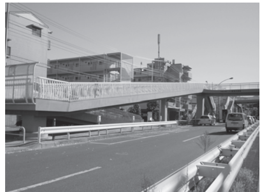
【写真10.1】 スロープの設置例
