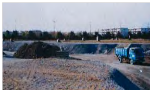
町田市最終処分場
