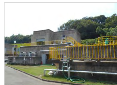
排水浄化センター外観
