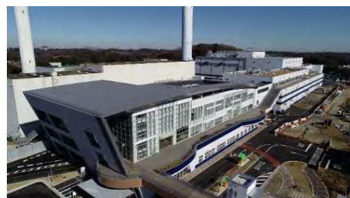
町田市バイオエネルギーセンター
