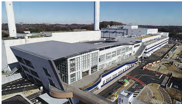
町田市バイオエネルギーセンター
