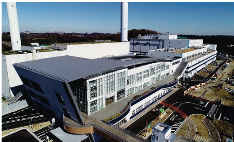
町田市バイオエネルギーセンター
