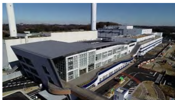
町田市バイオエネルギーセンター
