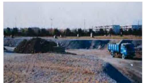
町田市最終処分場
