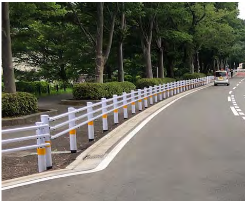
図 3-2-5 ガードパイプと横断抑止柵の設置
