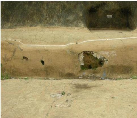
壁面被膜の剥落状況
