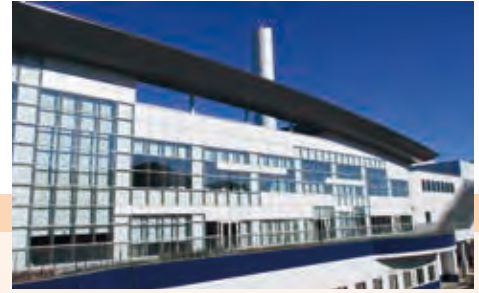
町田市バイオエネルギーセンター
