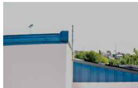
屋上に設置されたスプリンクラー
