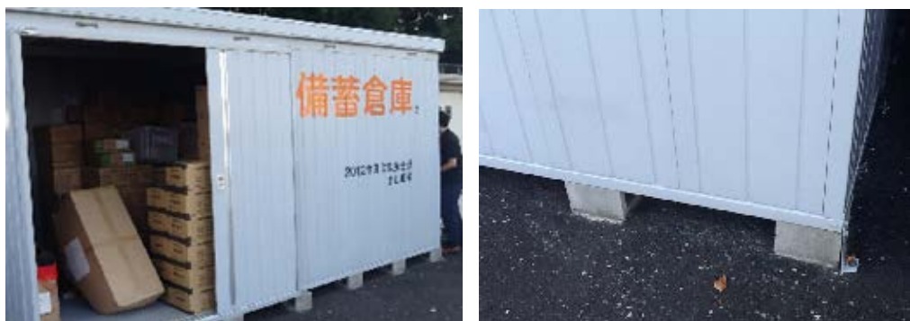
図 19 土台を設けていない例
