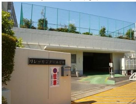
リレーセンターみなみ
