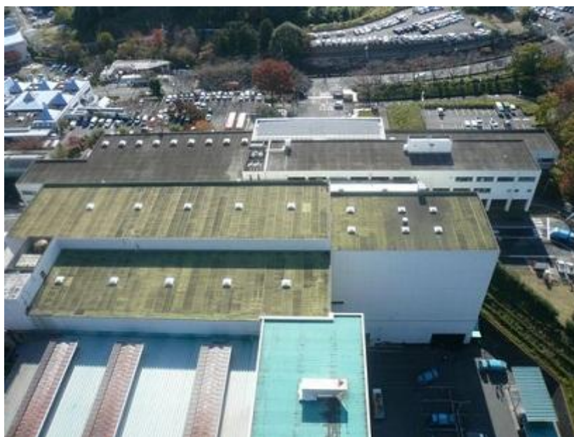
煙突から清掃工場を望む
