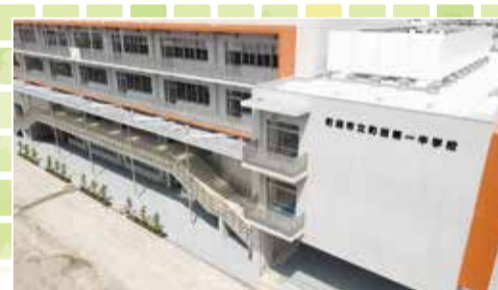
新しくなった町田第一中学校の外観
