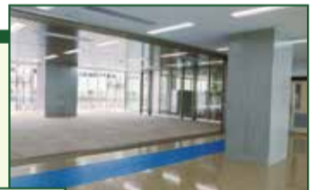
校舎中央に設置された交流ホール
