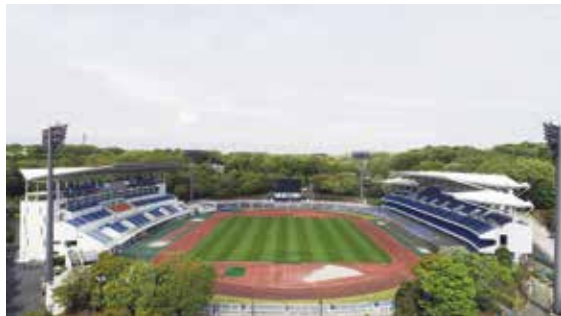
完成されたバックスタンド
