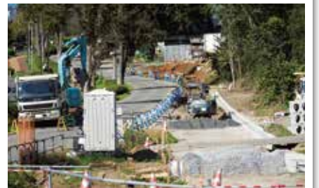
尾根緑道工事の様子
