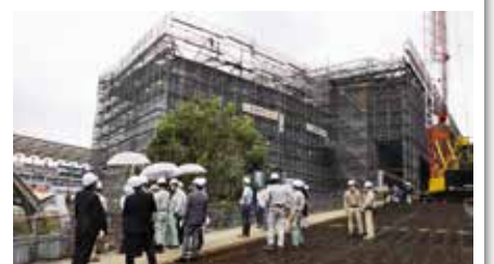
町田GIONスタジアムのバックスタンド増築工事の様子
