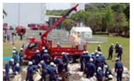
大型積土の工法の様子(昨年の訓練)
