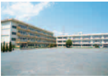
耐震補強工事が完了し、リニューアルオープンした教育センター
