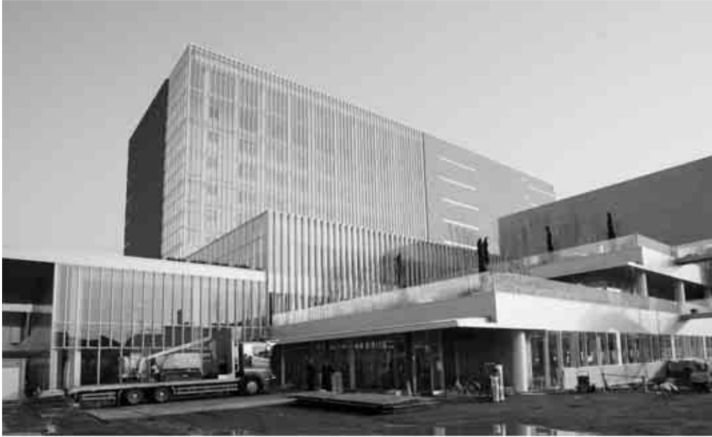
建設が進む新しい市役所
