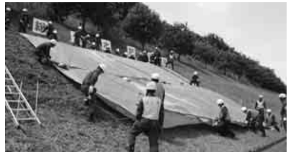
応急シート張り工法の様子(昨年の訓練から)
