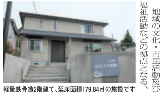
軽量鉄骨造2階建て、延床面積179.84㎡の施設です
