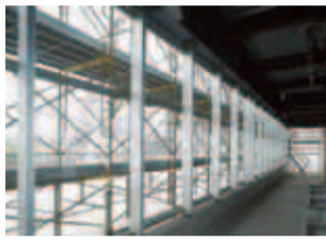
地上階窓枠取り付け工事の様子
