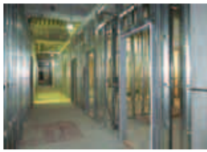
地下1階建具取り付け工事の様子
