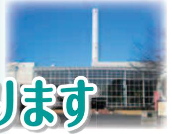
老朽化及び航空法の改正に伴い、清掃工場(下小山田町)の煙突に設置している航空障害灯の更新工事を行います。変更後は赤色灯が無くなり、塔頂部に白色灯が2灯のみとなります(左図参照)。また、近隣にお住まいの方へのまぶしさを抑えるため、白色灯の下側方向に遮光板を設置します。
