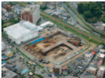
地下基礎工事 (2010年5月)
