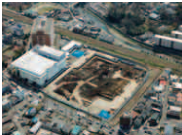
掘削工事 (2010年3月)
