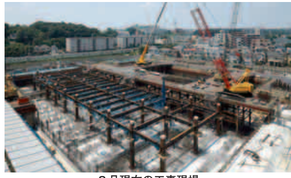
8月現在の工事現場
