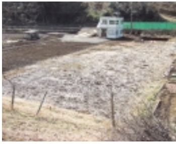
相原中央公園東側に位置する子どもセンターの建設予定地
