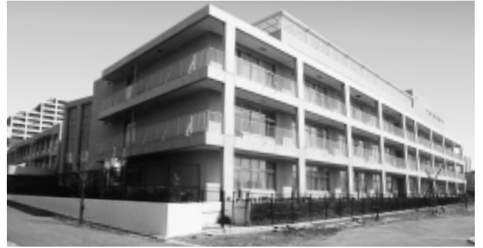
小山ヶ丘小学校が開校しました(普通教室・特別教室棟)
