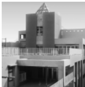
小山ヶ丘小2階昇降口(管理棟)
