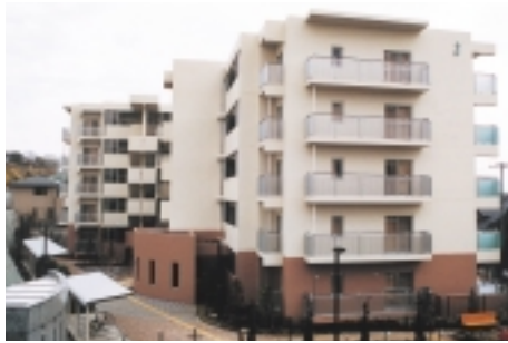
真光寺市営住宅ではユニバーサルデザインによる「すべての人のためのデザイン」の考え方を導入し、市営住宅では初めて集会所棟に屋上緑化がされています 5
