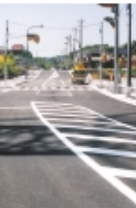
本町田の「菅原神社」交差点を起点に薬師台を通り、「真光寺十字路」交差点へ至る町田市計画道路3・4・35号線の芝溝街道を横切る部分が完成し、稲城・調布方面へのアクセスが容易になりました 7
