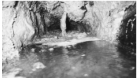
下水管に油が付着し、下水の流れが悪くなっているところ
