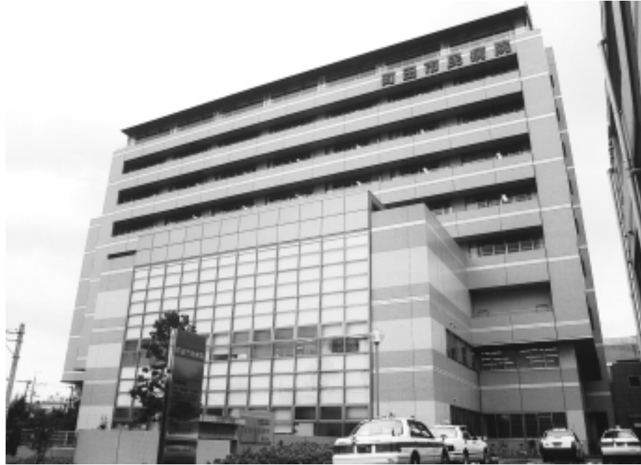
増改築工事が予定されている市民病院
