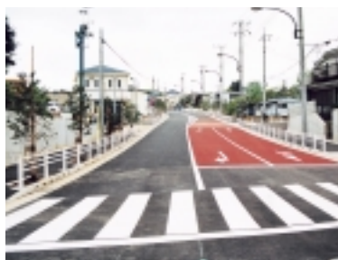
完成した都市計画道路3・4・30号線
