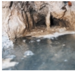
下水管に油が付着し、下水の流れが悪くなっているところ
