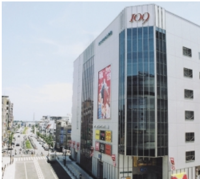
完成した原町田六丁目地区市街地再開発ビル
