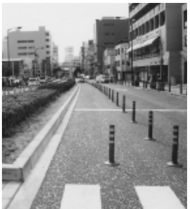
JR町田駅と町田街道を結ぶ都市計画道路3・4・11号線も完成に近づいています
