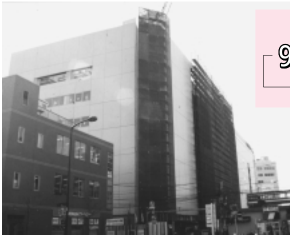
町田市公民館が入居する、原町田六丁目再開発ビルの建設工事が進んでいます。
