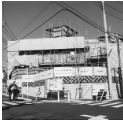
今年4月開園に向けて建設工事が急ピッチ で進む玉川から保育園。定員は67人で
