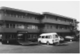
建て替え工事が完了した「清風園」
