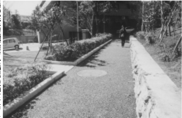
災害時の応急給水槽が設置された鶴川中央公園テニスコート横歩道。1万人分、3日間の飲料水が確保されます。
