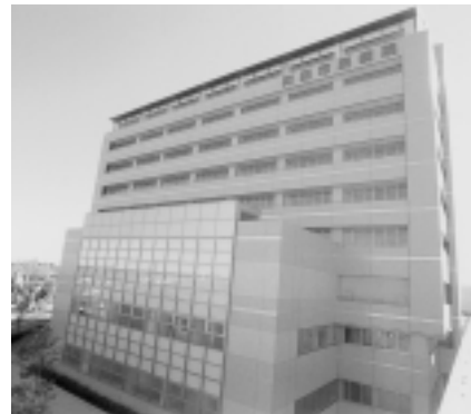
▶市民病院の新病棟が完成、東病棟として業務を開始しました③
