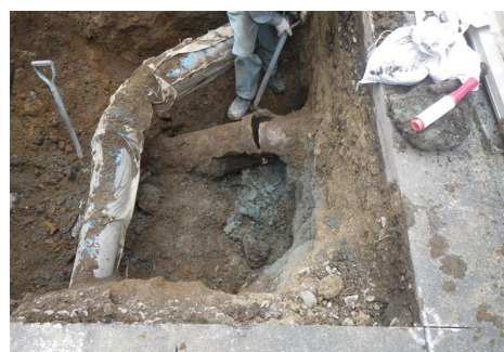
左官工法による補修の様子
