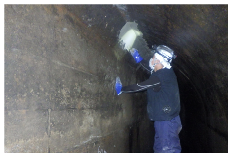
左官工法による補修の様子
