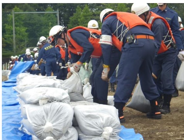
水防工法を行う様子
