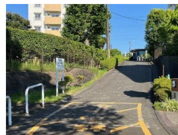
車椅子による登りが困難な急勾配箇所
