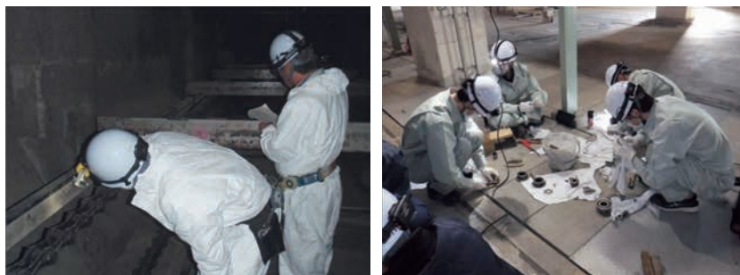
図5-3 設備の点検・調査作業（左）、設備の補修・修繕作業（右）
