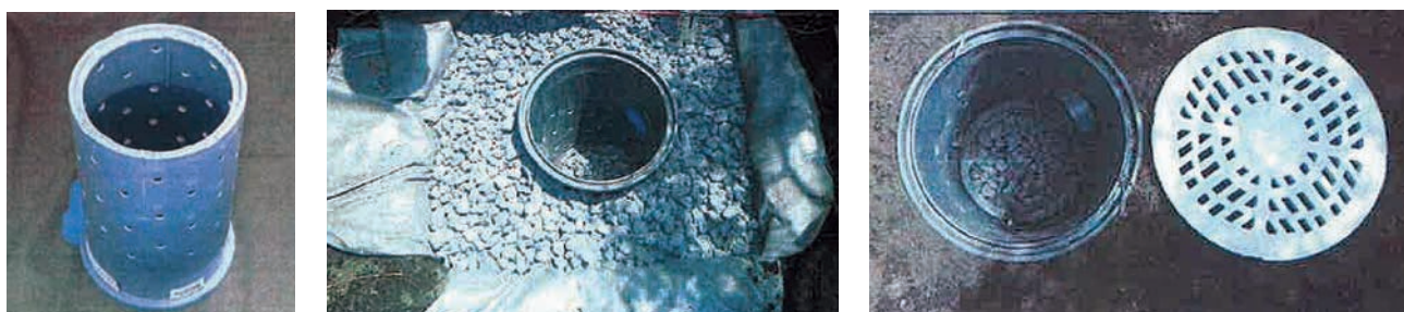
図6-9 雨水浸透設備
