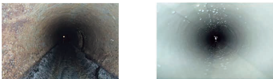
図6-30 更生工事前のコンクリートが劣化した下水道管（左）、更生工事後の下水道管（右）
