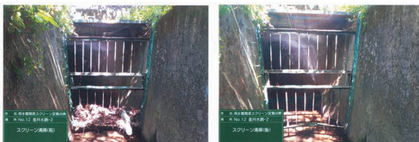
図6-10 事前点検パトロールによるスクリーン清掃前後
