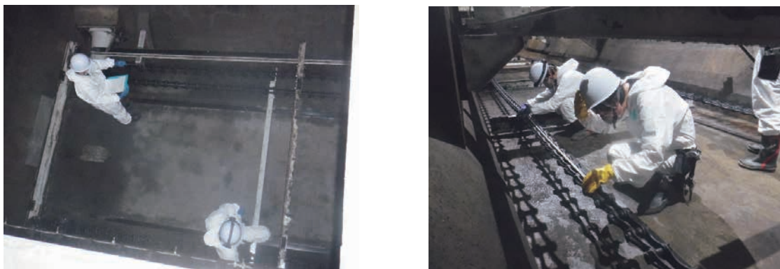
図6-24 汚泥掻き寄せ機の詳細調査状況写真
