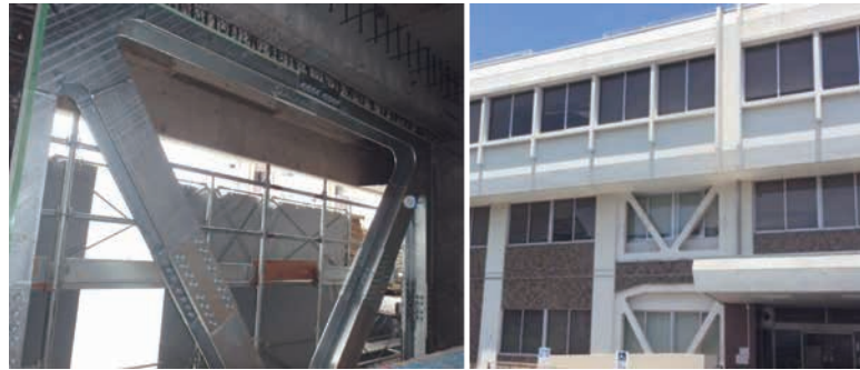
図6-20 耐震補強工事中の建物（左）、耐震化工事完了後の建物（右）
